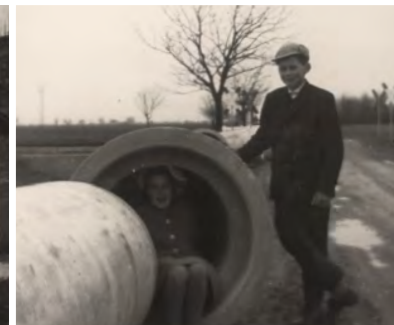
Oben: Ursprünglicher Lauf des Ehebachs Unten: Das neu gebaute Winzerhaus; Kanalisationsarbeiten in der Wiesenstraße
